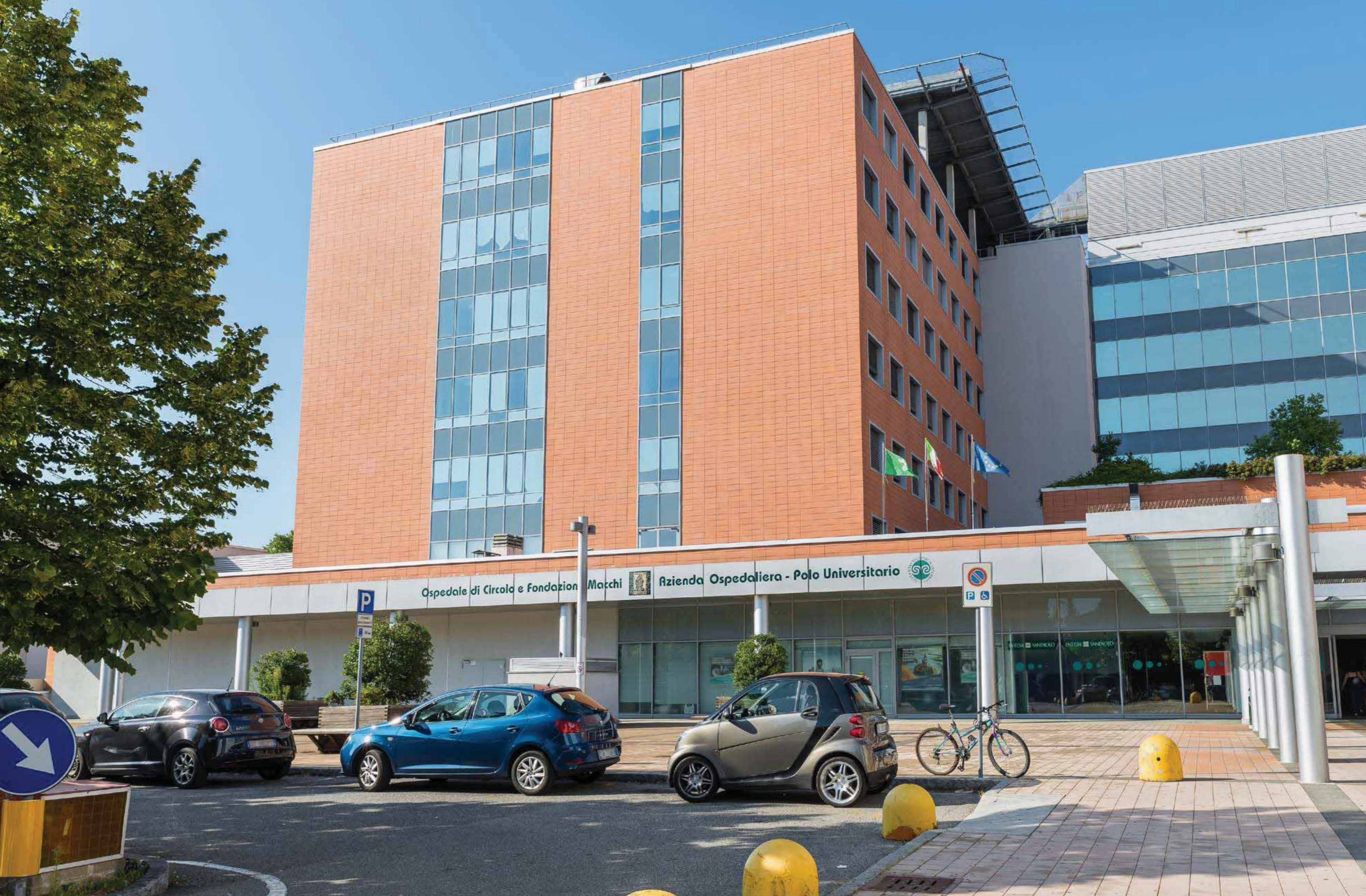
Ospedale di Circolo - Macchi foundation Varese, Italy
